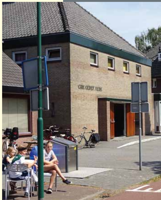
Gebouw Oranjekerk in het centrum van Driebergen, aan de Oranjelaan, vlakbij De Traaij
